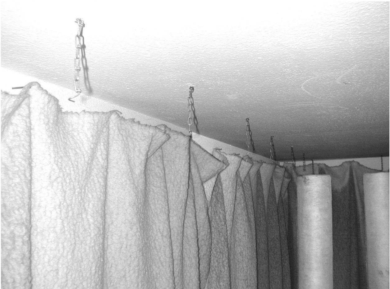
Nur Ketten sind geblieben, wo Schallschluckelemente hingen - als Boxbirnen waren sie schließlich nicht gedacht ... Zustand am 22.5.08. (Phot.: Verf.)
